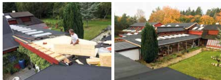
Vores lokale tømrer, Egon, færdiggør tagrenoveringen.
